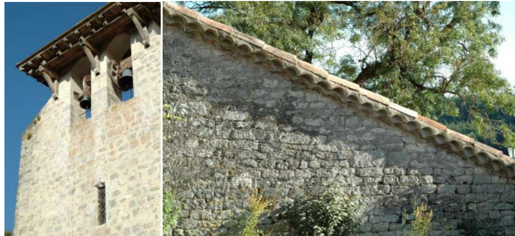
Figure 169 : Murs de calcaire blanc et toiture de tuiles ocre à LEBREIL- Auteur : Amélie VALLON
