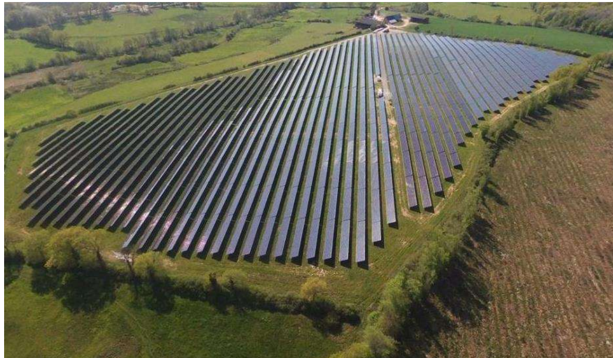
Figure 3: Photo d'un parc photovoltaïque développé par Photosol
